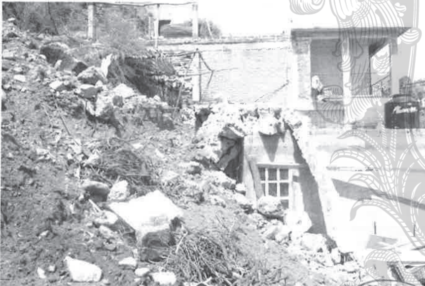
Daños por inestabilidad de laderas en la Comunidad de Chichimequillas en el municipio de Silao de la Victoria. Fuente: (CEPC, 2018).
